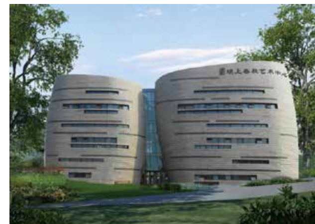
已落成的天津坝上春秋艺术中心 The completed Century Times Art Center in Tianjin
