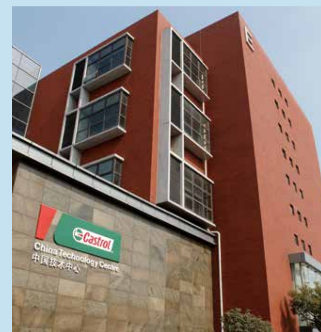
BP 嘉实多中国技术中心 BP-Castrol China Technology Centre
