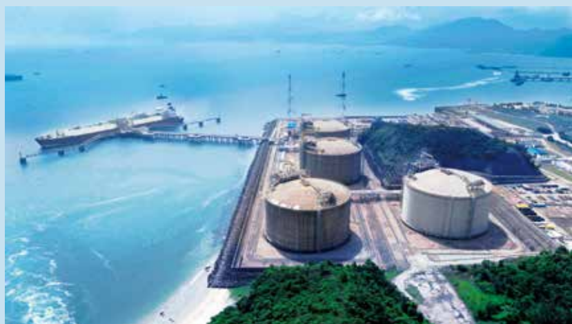
位于深圳的大鹏 LNG 接收站 Dapeng LNG Terminal in Shenzhen
