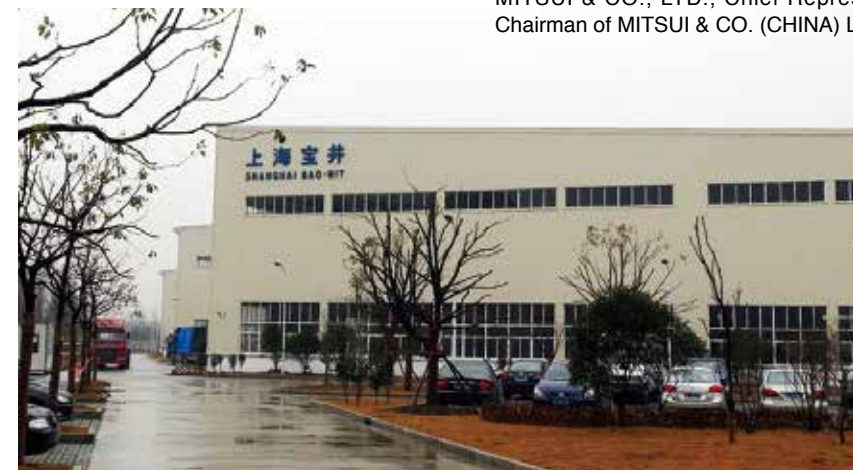
上海宝井外景 Exterior of Shanghai Bao-Mit
