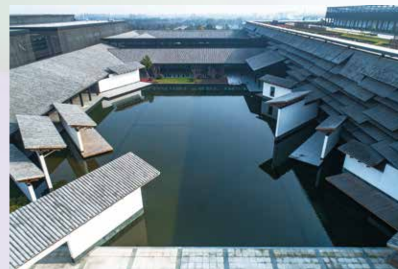
乌镇互联网国际会展中心使用了圣戈班哈比特板，不仅能够提供健康环保的会议环境和完善的防火安全保障，同时低膨胀收缩率保证了饰面材料与基层完美契合成一体。
